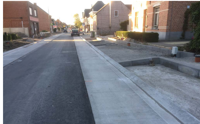
Heraanleg Pastoriestraat Baal zonder fietspaden. Onbegrijpelijk!!
